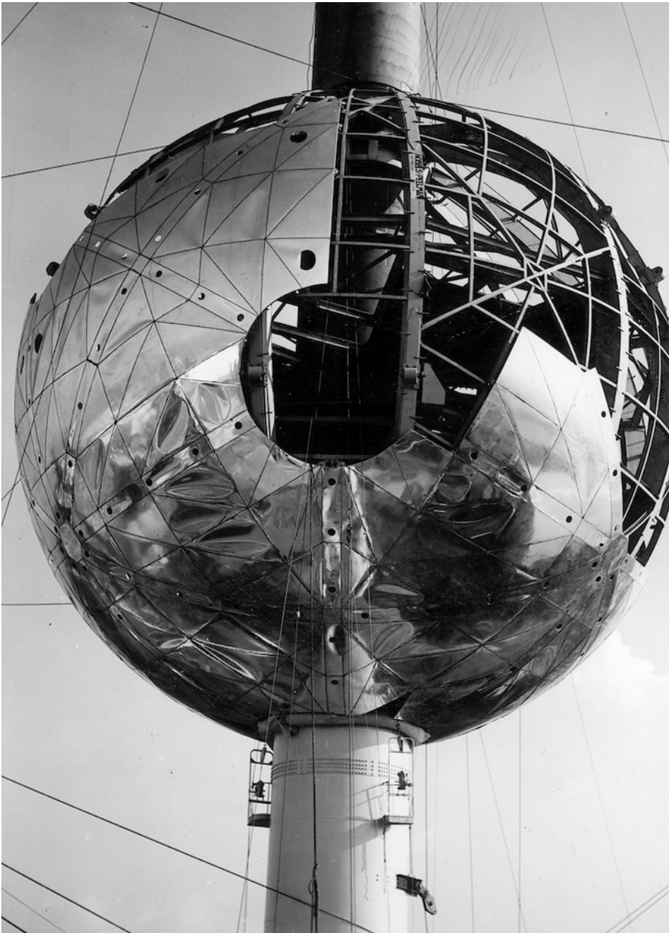
Chantier de l'Atomium pour l'Expo 58 de Bruxelles, 1957, André et Jean Polak (architectes), André Waterkeyn(ingénieur). Archives de l'Atomium.
